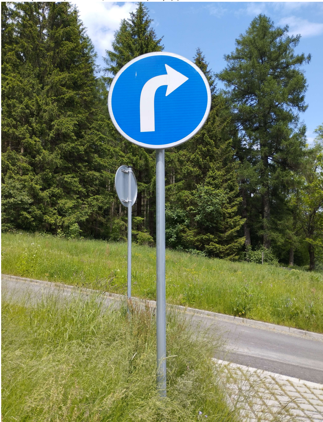
Foto 3: Stávající zařízení dopravního značení, ukazatel: Přikázaný směr jízdy vpravo
