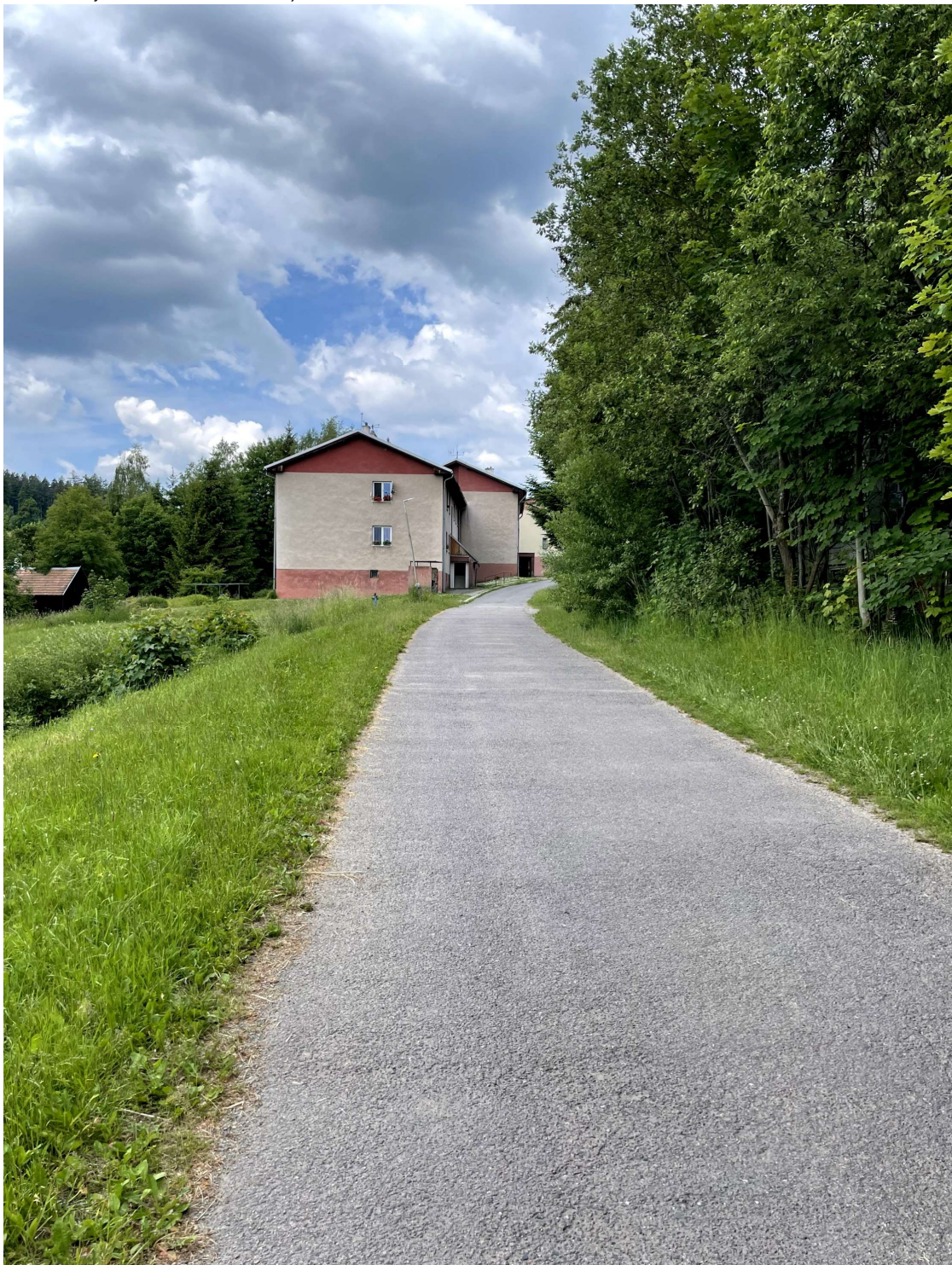
Foto 2: Stávající místní komunikace III. třídy
