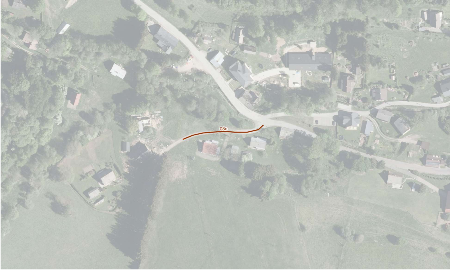
Obrázek A.4.1.8: Místní komunikace III. třídy (08c)
