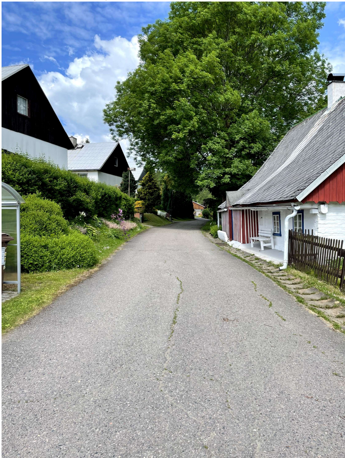
Foto 1: Stávající místní komunikace III. třídy
